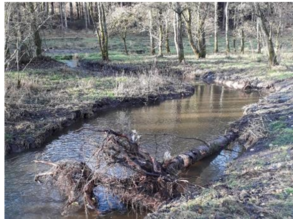
Cours d'eau après travaux de renaturation
